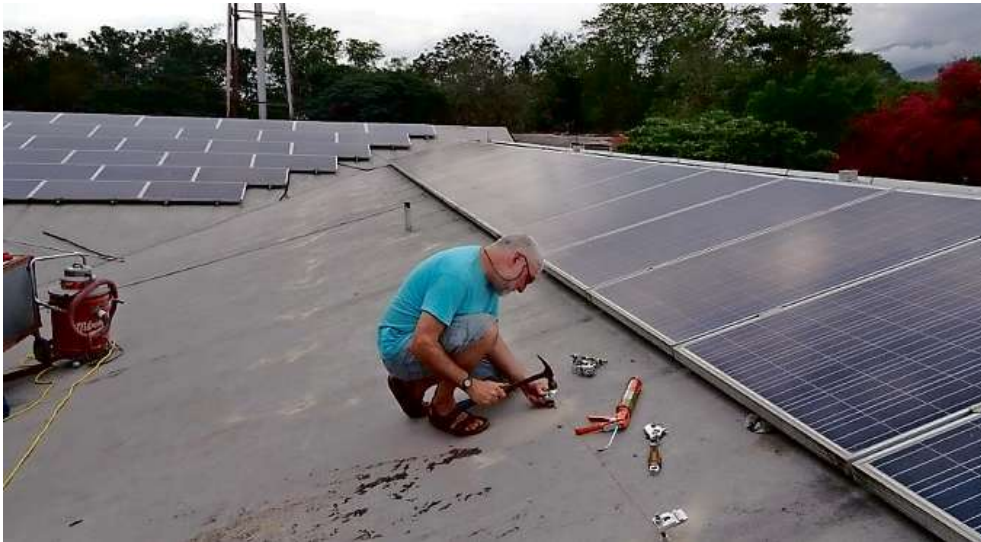
Christian Hassler legt auf dem Dach des Albert-Schweitzer-Spitals in Deschapelles selber Hand an. Pressebilder
